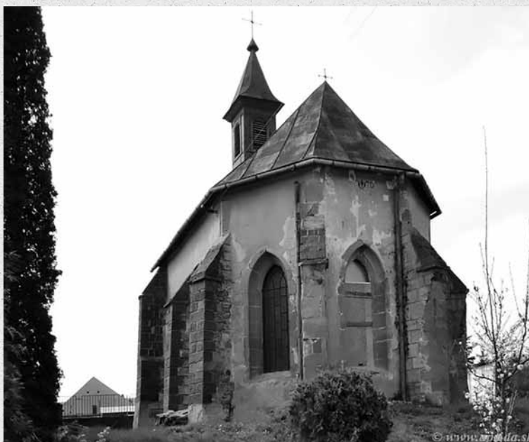
Kaplnka sv. Kunhuty vo Veľkom Šariši, bývalé presbytérium kláštorného kostola sv. Stanislava, 14. storočie.
